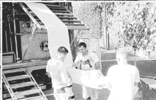
Fast 2000 laufende Meter Nadelfilz und 26 Tonnen Harz lieferten die Vereinigte Filzfabriken Giengen nach Moskau. Dort werden auf dem Areal der deutschen Botschaft marode Rohre und Kanäle saniert. Fotos: vfg
